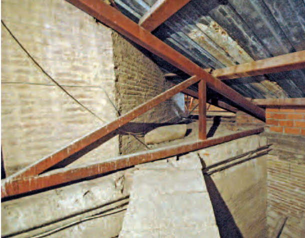
12. Calatayud (Zaragoza). Santo Sepulcro, arranque de la cúpula visible en el bajocubierta. Se observa el extremo de una de las piezas del encadenado, dispuesto, como en Santa María, en la base del tambor.
