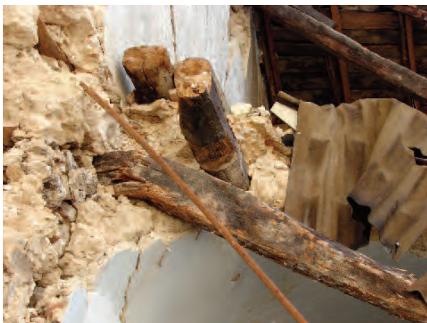
10. Villa Sant'Angelo (AQ). Volta a botte rinforzata con elementi lignei tra loro ortogonali e immersi nell'apparecchio murario.
