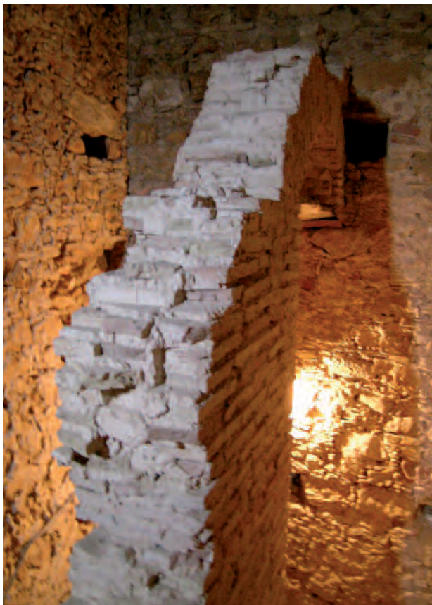
7. Piazza Armerina. Chiesa Madre, archi rampanti in laterizio.
