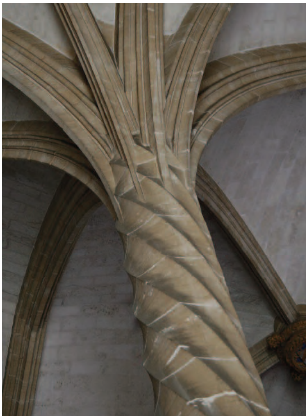
8. G. Sagrera, lonja de Mallorca, detalle del encuentro de los nervios de la cubierta con el pilar helicoidal (foto de M. Morey).
