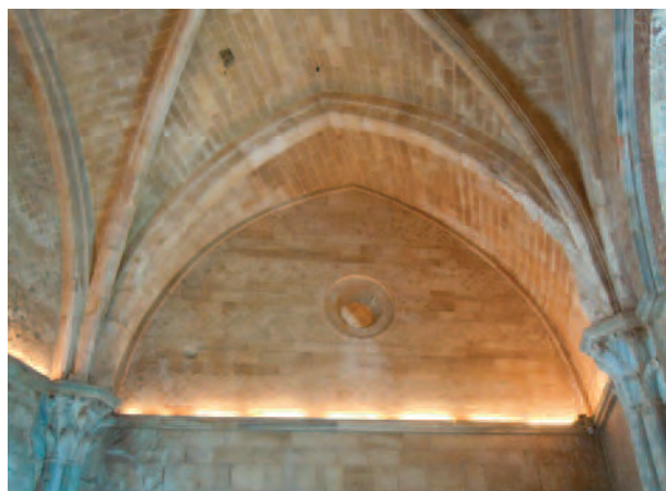
6. Castel del Monte, Voûtement d'une salle à l'étage (cliché D. Sandron).
