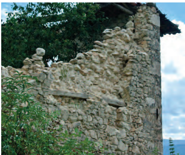
6. Poggio Picenze (AQ). Un radiciamento realizzato con un elemento ligneo squadrato e, sull'angolo, il capochiave del radiciamento della parete ortogonale.
