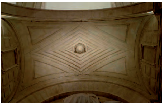
9. Bóveda de la capilla de acceso a la actual capilla de comunión de la colegiata de Xàtiva. Fotografía J. Bérchez.
