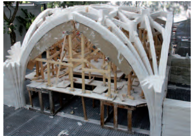
12. La bóveda ya terminada revela su rampante llano originado por la estandarización de sus arcos principales.
