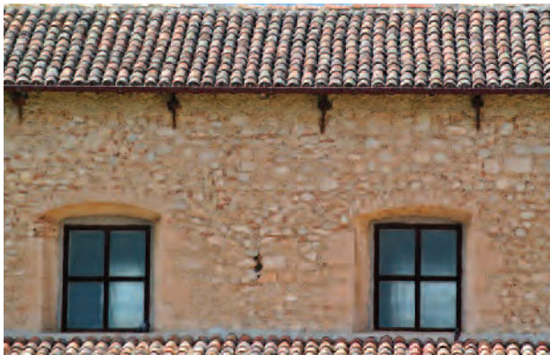
12. Petogna (AQ). Vista dall'esterno dei paletti lignei (impalettature) di ancoraggio delle mensole delle capriate di una chiesa.
