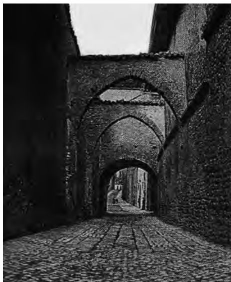
2. L'Aquila. Via dell'Annunziata, archi di collegamento tra edifici (foto d'archivio, per gentile concessione di CARSA Edizioni, Pescara).
