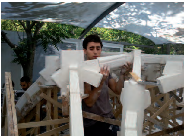
11. Invariablemente, entre las claves, sólo cabe una dovela.
