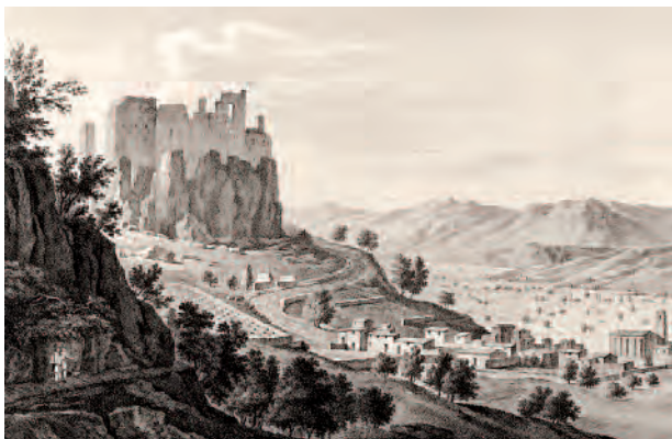
2. A. Laborde, Grabado de las ruinas del Castillo de Montesa, hacia 1820.
