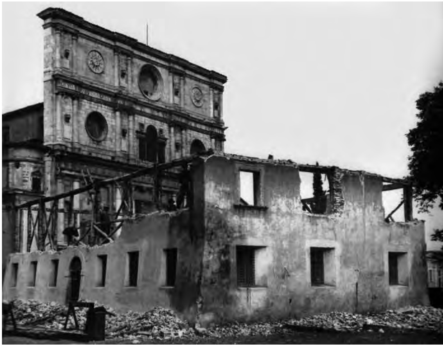
4. L'Aquila. Edificio baraccato settecentesco in corso di demolizione (foto d'archivio, per gentile concessione di CARSA Edizioni, Pescara).
