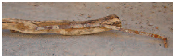
7. Villa Sant'Angelo (AQ). Un radiciamento con ancoraggio metallico terminale estratto dalle macerie di un edificio crollato.
